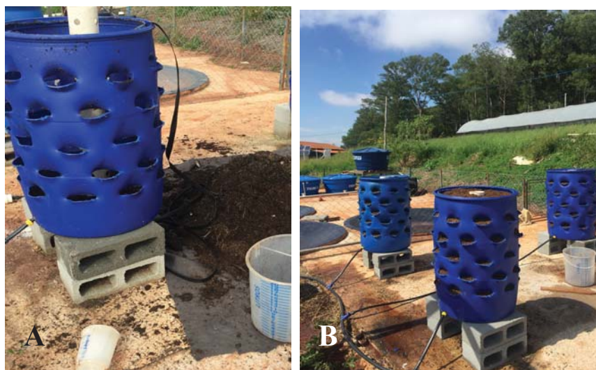
Figura 3. (A) Instalação da fita de gotejamento. (B) Sistemas instalados na área de pesquisa do Departamento de Engenharia Rural da UNESP/FCA.
