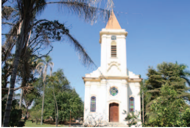
Figura 3. Vista da Igreja, hoje Patrimônio Histórico, construída na época do antigo "Asilo Colônia Aymorés", em Bauru/SP.
