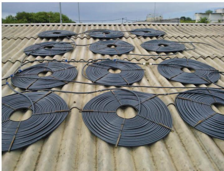
Cada sistema com 12 serpentinas aquece 2000 litros de água por dia.
