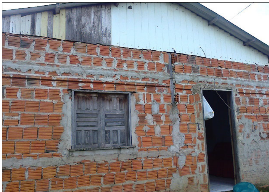
Foto: Alessandra Manchinery, em 2013.
