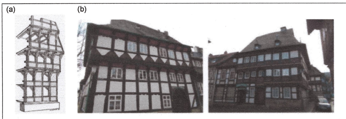
Figura 1. Sistema construtivo baixo-saxão e seu uso em casas na cidade de Goslar (Alemanha).
