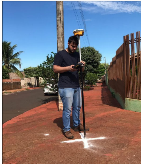
Figura 9. Coleta das coordenadas de apoio.
