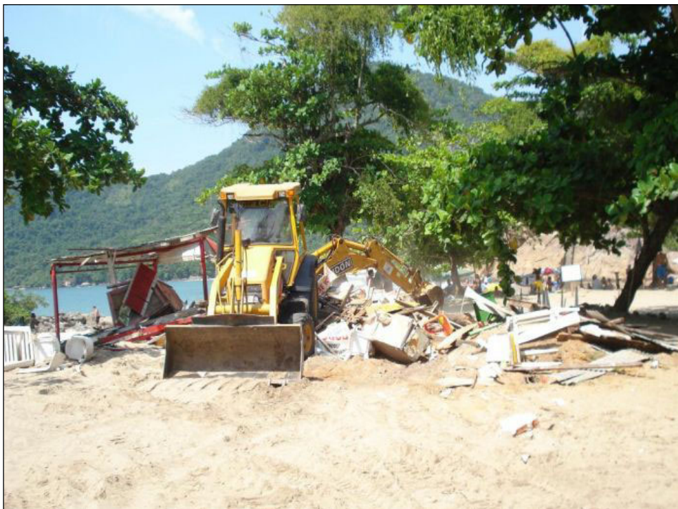
Figura 4. Retirada de construção da Praia do Meio (Fonte: Santos, L.B., 2016).
