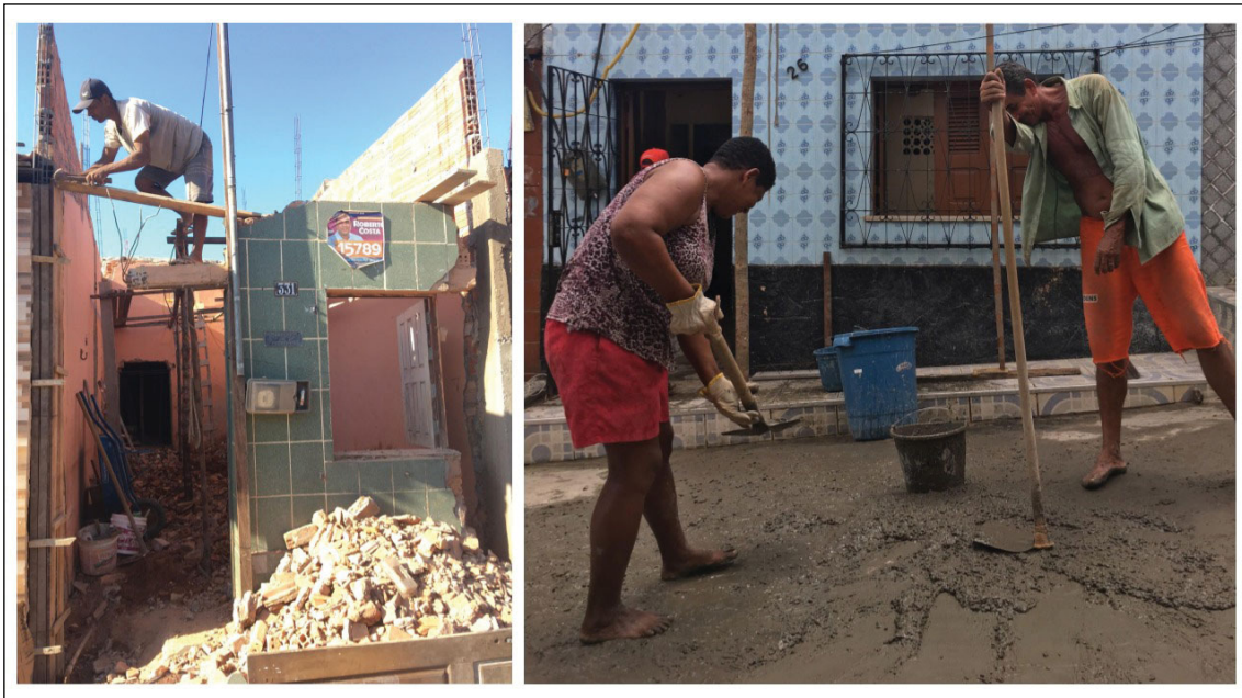
Figura 5. Acompanhamento das obras.
